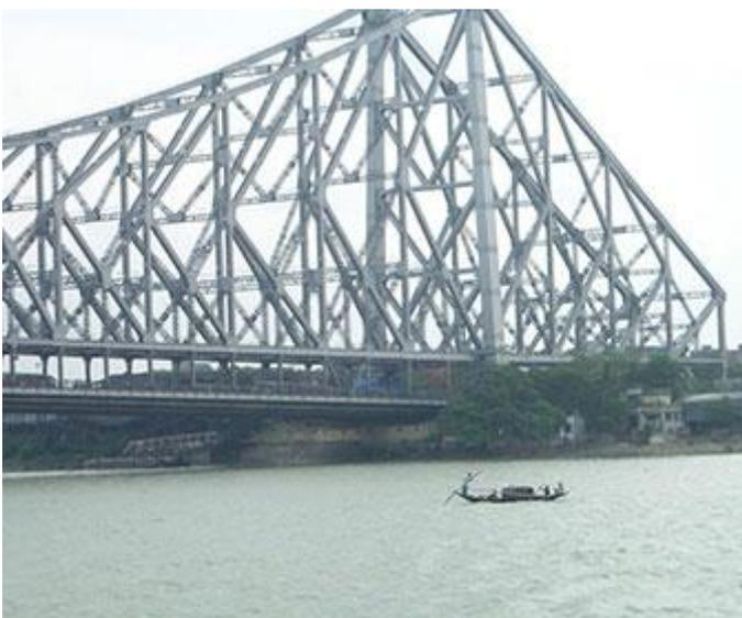
È stato costruito con 26.500 tonnellate di acciaio, di cui 23.000 tonnellate di una lega ad alta resistenza fornita da Tata Steel.
