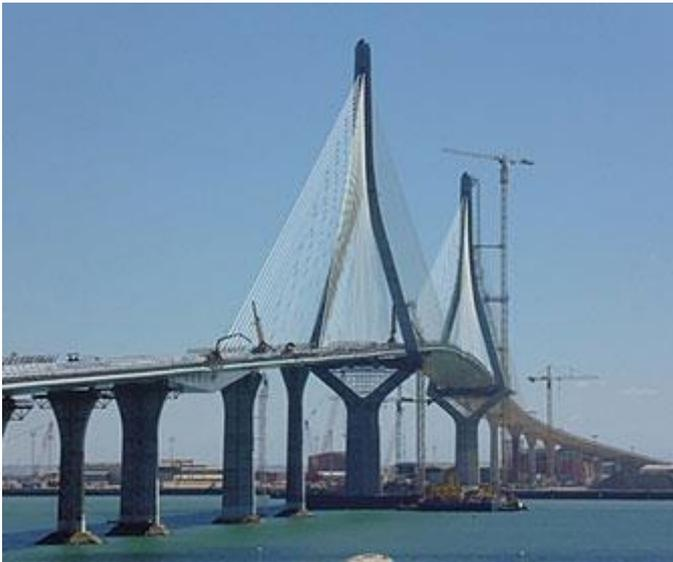
Il ponte della Costituzione del 1812, è un ponte strallato (ponte il cui ponte è sospeso da uno o più piloni centrali mediante cavi), con una lunghezza totale di 3092 m. (1440 di cui sopra l'acqua), che attraversa la baia di Cadice. È stato inaugurato il 24 settembre 2015.
